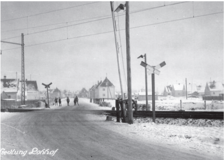
Die Bahnschranke von Unterschleißheim in die Bezirksstraße
